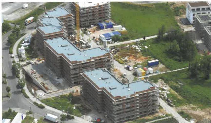
Die 124 Wohnungen im Stadtteil Nilkheim sind kurz vor der Fertigstellung.
